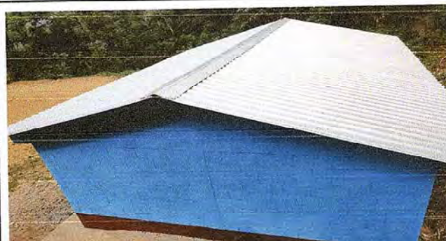
Foto 2: instalacion de laminas troqueladas aluzinc cal. 26
