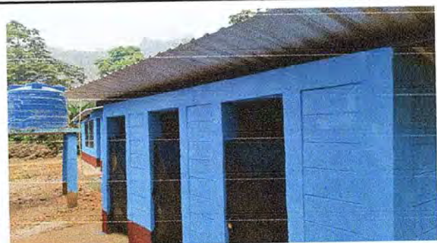
Foto 4: sustitucion de laminas de los baños.
