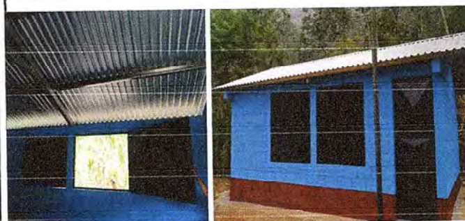
Foto 3: suministro e instalacion de puerta con chapa y 4 ventanas. (En la parte de enfrente y atrás)
