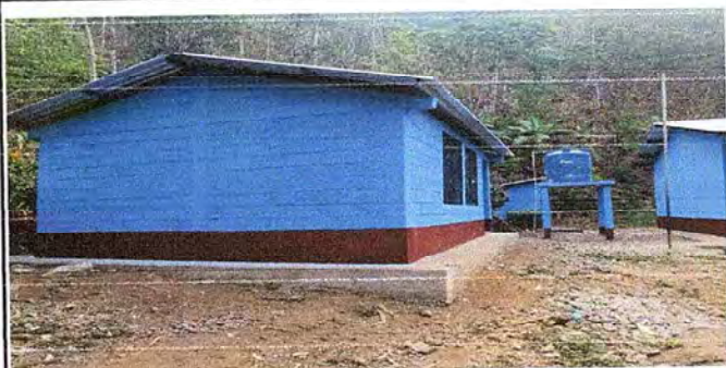
Foto 1: cocina ya terminada, ya se mira la diferencia.
